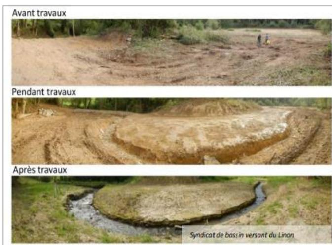
Figure 173 : Bras de contournement réalisé en 2017 sur l’étang du Moulin - SAGE RFBB
