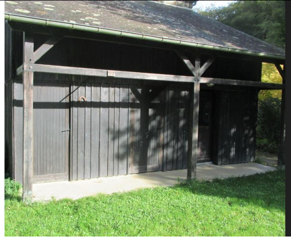
Hangar et local éclusier à l'arrière de la maison éclusière
