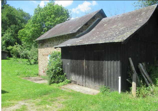
Remise à l'arrière de la maison éclusière
