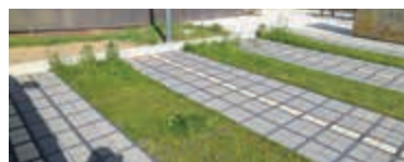
Stationnements végétalisés avec infiltration gravitaire du ruissellement
